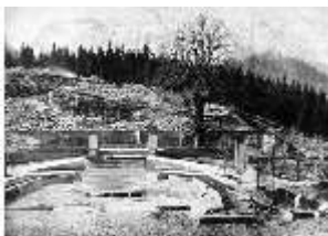
LIIMus.III: Foto Baustelle Linderhof, Lin., DE002499, BSV-
