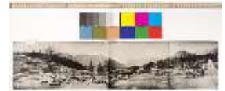
LIIMus.III, Foto der Baustelle Linderhof, Lin., DI013104, BSV-
